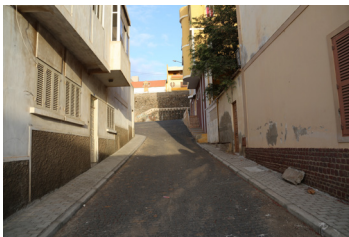
Figura 37 – Fotografia 3 – Rua perpendicular para a Rua do Morguin _ Rua da Craca.
