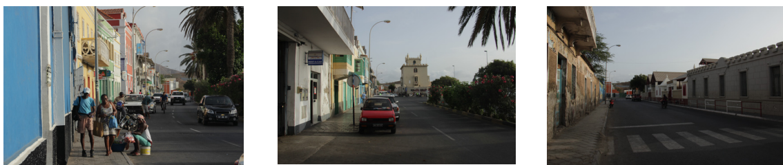
Figura 25 – Fotografia 11 – Rua da Praia. | Fotografia 12 – No fundo a réplica da Torre de Bélem | Vista A – Edifício do Mercado de peixe e a antiga Quintalona.
